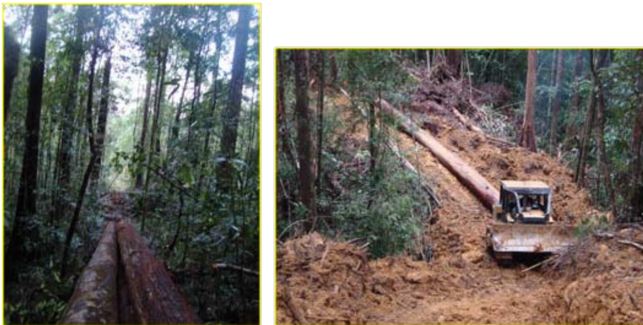
Gambar 12: Perbandingan kegiatan penyaradan kayu dengan menggunakan mesin pancang atau monocable winch (MCW) dan dengan menggunakan buldozer (Griscom, B et al, 2013)
